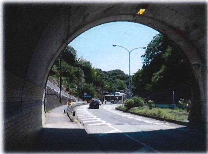
トンネルを抜けます
